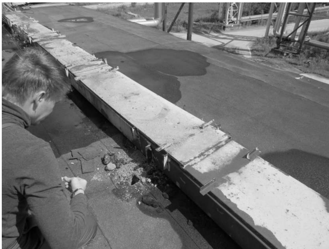
Фото 6. Выполнение вскрытия кровли в осях А-Б/1-2.
