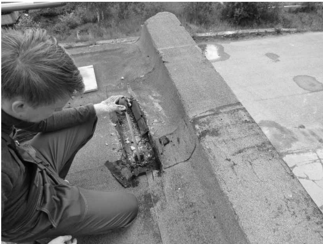
Фото 6. Выполнение вскрытия кровли в осях А-Б/1-2.
