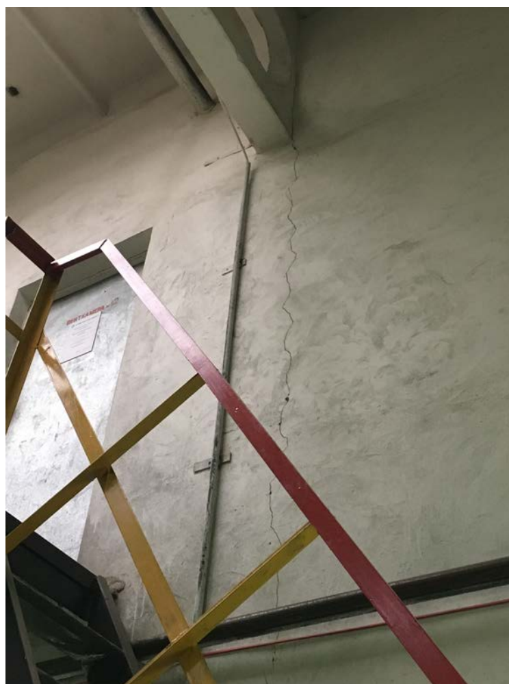
Фото 4 – Трещина в самонесущей стене в осях «2/В» шириной раскрытия 3мм и длиной 4000мм.
